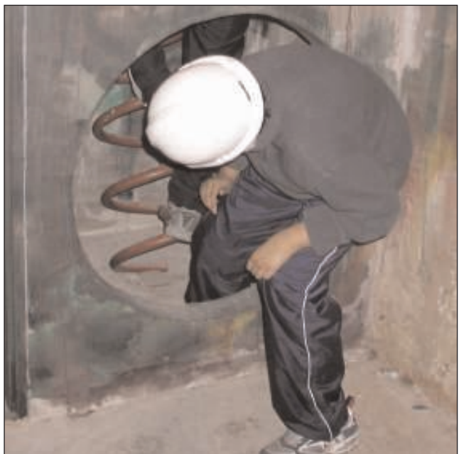
Spildevandstunnelen på Energi- & Vandværkstedet
